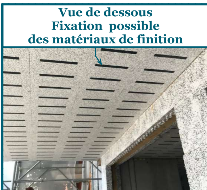
Coffrage périphérique de dalle du balcon
